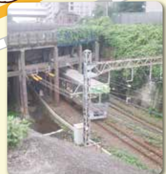
幻の山手急行線遺構 (左のトンネル)
